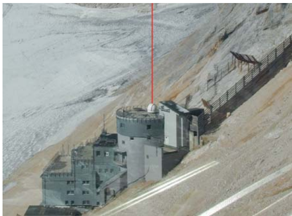
Abbildung 3 Standort „Schneefernerhaus“ mit Kuppel zur Wasserdampfmessung mittels Lidar
